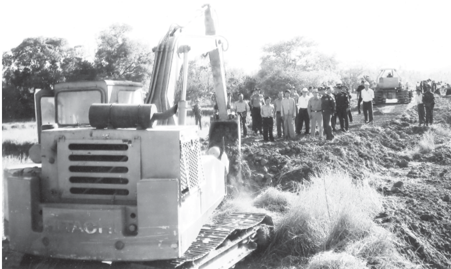
ရောဝတီတိုင်း အေးချမ်းသာယာရေးနှင့် ဖွံ့ဖြိုးရေးကောင်စီဥက္ကဋ္ဌ၊ အနောက်တောင်တိုင်းစစ်ဌာနချုပ် တိုင်းမှူး ဗိုလ်မှူးချုပ်ကျော်ဆွေ၊ ငရုတ်ကောင်းမြို့ ရေကျော်ကျေးရွာအုပ်စု စမ်းချောင်းကျေးရွာတွင် ကမ်းခြေမြေသားလမ်းအား စက်ယန္တရားများဖြင့် ဖောက်လုပ်နေမှုကို ကြည့်ရှုစစ်ဆေးစဉ်။ (သတင်းစဉ်)
