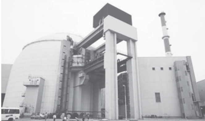
အီရန်နိုင်ငံ တီဟီရန်မြို့တောင်ဘက် ၇၅၅ မိုင်အကွာရှိ တည်ဆောက်ဆဲ အထူးမြောက်ပေါင်းဖိုကို ဒီဇင်ဘာ ၂၄ ရက်က တွေ့ရစဉ်။ (ဓာတ်ပုံ-အင်တာနက်)
