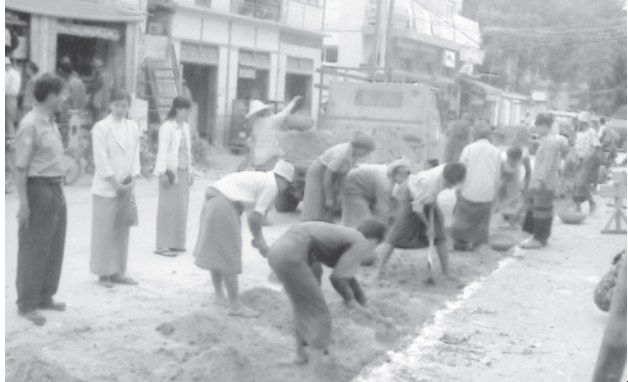
ကျောက်ပန်းတောင်းမြို့ မရပ်ကွက် ဗိုလ်ချုပ်လမ်းတွင် လမ်းပန်းထက်မြင့်သော မြေသားများ ပြုပြင်ခြင်းလုပ်ငန်းကို အငယ်တန်းအင်ဂျင်နီယာ-၂(မြို့ပြ) ဒေါ်မော်မော်ဦး လုပ်ငန်းဆောင်ရွက်နေမှုကို မြို့နယ်စည်ပင်သာယာရေးအဖွဲ့ အမှုဆောင်အရာရှိ ကြီးကြပ်ဆောင်ရွက်စဉ်။
