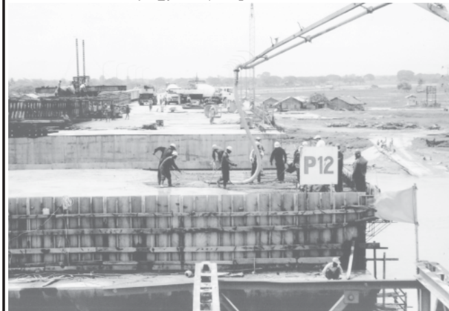
P 12တွင် နောက်ဆုံးအဆင့် ကွန်ကရစ်လောင်းခြင်းလုပ်ငန်း ကို ဆောင်ရွက်ကြစဉ်။
