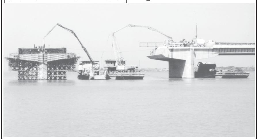
ရေလယ်တိုင် P 13 အစွန်းထွက်ရက်မ ကွန်ကရစ်လောင်း ခြင်းလုပ်ငန်းကို (Pump Truck) နှစ်စီးဖြင့် ဆောင်ရွက်စဉ်။
