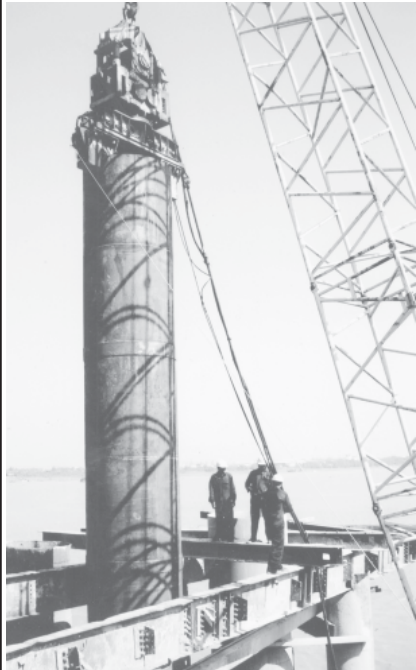
Stand Pipe ရိုက်သွင်းခြင်းလုပ်ငန်း ဆောင်ရွက်နေစဉ်။
