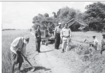
ရန်ကုန်တိုင်း တိုက်ကြီးမြို့နယ် စည်ပင်သာယာရေးအဖွဲ့က ကပြသစမ်း-ကသုံးဆေး ကျေးရွာချင်းဆက် မြေသားလမ်း မောက်လုပ်ခြင်း လုပ်ငန်းအား စက်ယန္တရားဖြင့် ဆောင်ရွက်လျက်ရှိရာ စက်တင်ဘာ ၈ရက်က အမှုဆောင်အရာရှိ ဒုတိယညွှန်ကြားရေးမှူး ဦးတင်ဝင်းနှင့် လက်ထောက်အင်ဂျင်နီယာ ဦးဝင်းလှိုင်တို့ ကွင်းဆင်းကြီးကြပ် ဆောင်ရွက်စဉ်။ (မြို့နယ်စည်ပင်)
