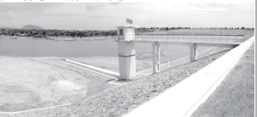
မကွေးတိုင်း ပခုက္ကူခရိုင် ရေစကြိုမြို့နယ် ငွေချိုကျေးရွာအနီး ဆင်မောင်းချောင်းကိုပိတ်၍ တစ်အလျားပေ ၁၅၀၀၀၊ အမြင့် ၅၇မီတာရှိ လယ်မြေဧက ၄၀၀ ဆည်ရေပေးပေးနိုင်မည့် ငွေချိုရေလျှောင့်တံနှင့် ရေထိန်းမျှတစင်ကို ရှင်မတောင်တောင်တန်း နောက်ခံ၍ ဤသို့တွေ့ရသည်။ (ဓာတ်ပုံ-မြန်မာ့အလင်း)
