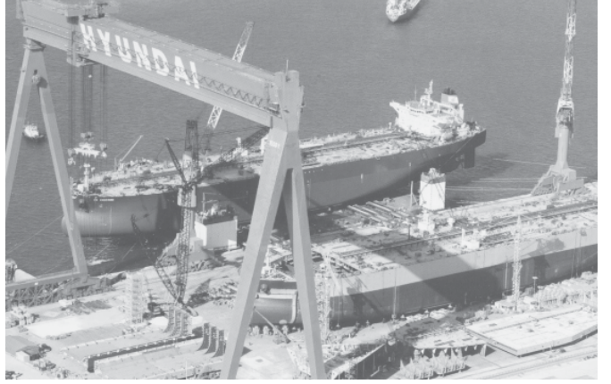
တောင်ကိုရီးယားနိုင်ငံရှိ သင်္ဘောကွင်းတွင် ကုန်တင်သင်္ဘောကြီးတစ်စင်း တည်ဆောက်နေသည့်ကို ဇွန် ၂၄ရက်က တွေ့ရစဉ်။ (ဓာတ်ပုံ-ကိုရီးယားရီဗျူး)
