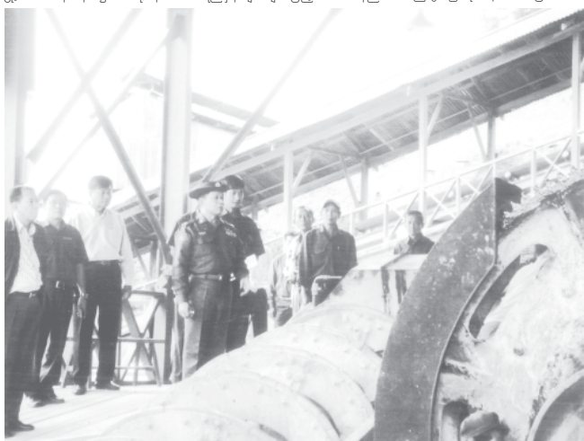
သတ္တုတွင်းဝန်ကြီးဌာန ဝန်ကြီး ဗိုလ်မူးချုပ်အုန်းမြင့် သတ္တုရိုင်း သန့်စင်ရေးစက်ရုံတွင် ကြည့်ရှုစစ်ဆေးစဉ်။ (သတင်းစဉ်)
