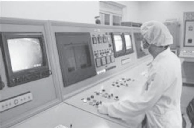
အီရန်နိုင်ငံအစိတ်ကုန်ရှိ ယူရေနီယံအားဖြည့်လောင်စာ ထုတ်လုပ်ရေးအကူပြုစခန်းတစ်ခုရောက်ရှိ ထိန်းချုပ်ခန်းကို ဖေဖော်ဝါရီ ၂၃ ရက်က တွေ့ရစဉ်။ (ဓာတ်ပုံ-အင်တာနက်)
