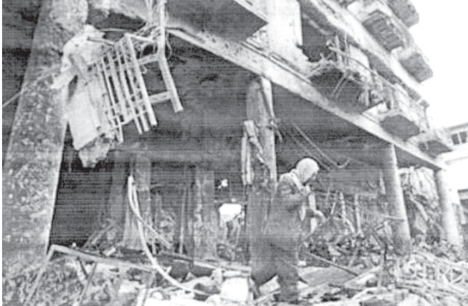
အီရတ်နိုင်ငံ ဘဂ္ဂဒတ်မြို့ ဈေးတစ်ချောင်း ကားပေါက်ကွဲပြီးနောက် အပျက်အစီးများကို ဖယ်ဖျက်ရာတွင် ၄ ရက် က တွေ့ရစဉ်။ (ဓာတ်ပုံ-အင်တာနက်)
