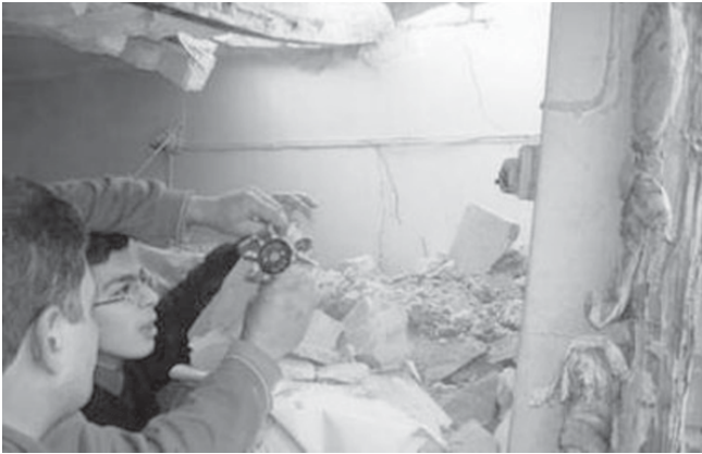
အီရတ်နိုင်ငံ ဘဂ္ဂဒက်မြို့၌ မိန့်ပြောင်းကျည်ထိမှန်မှုကြောင့် ပျက်စီးသွားသော အဆောက်အအုံတစ်ခုကို ဇန်နဝါရီ ၃၀ ရက်က တွေ့ရစဉ်။ (ဓာတ်ပုံ-အင်တာနက်)
