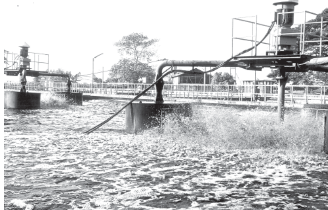
တစ်နေ့လျှင် ရေဆိုးဂါလန်သုံးသန်းခန့်ကို သန့်စင်ပေးနေသည့် ရေဆိုးသန့်စင်စက်ရုံ၏ ရေလုပ်ငန်းဆောင်ရွက်နေမှုကို တွေ့ရစဉ်။
