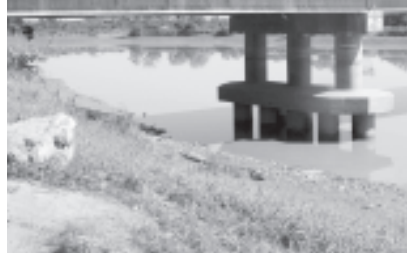
သာကောမြို့ဘက်ရှိ သုဝဏ္ဏမြို့ဘက်တွင် တည်ဆောက်နေသော ကမာကြည်တံတား
