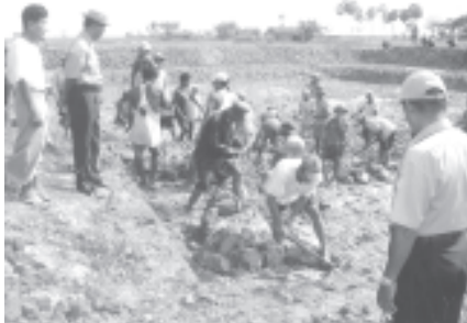
မုန်ဖြူ ဘလောက်ညောင်ပိုင်မိုးကျေးရွာတွင် သောက်သုံးရေ မလုံစွာရရှိစေရန် အတွက် မိုးရေလျှောက်ကန်တူးဖော်ခြင်းလုပ်ငန်းကို ဆောင်ရွက်လျက်ရှိရာ ဇွန် ၅ရက်က မြို့နယ်စည်ပင်သာယာရေးအဖွဲ့ အမှုဆောင်အရာရှိ ဦးဖုန်းလှနှင့် လက်ထောက်အင်ဂျင်နီယာ ဦးစိုးနိုင်တို့ လုပ်ငန်းစဉ်ကို ကြိုကြပ်ဆောင်ရွက် ရေးကြစဉ်။ (၃၀၇)
