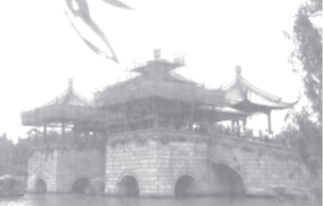
တရုတ်နိုင်ငံ ကျန်ရည်နယ် ယောင်ကျူမြို့ရှိ ကန်တော်ကြီးတွင် မုခ်ဦးတံတား တည်ဆောက်နေသည့်ကိစ္စ မေ ၂၇ ရက်က တွေ့ရစဉ်။
