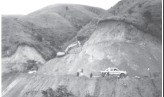
ကျိုင်းတုံ-ခိုင်းယျဉ်း-တာကော်လမ်းသစ် မြင်ကွင်းကို တွေ့ရစဉ်။
