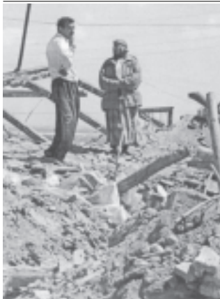
မတ် ၃၁ ရက်က အီရန်နိုင်ငံအနောက်ပိုင်း ဓါလက်အလီ ကျေးရွာတွင် မြေငလျင်ကြောင့် ထိခိုက် ပျက်စီးမှုများကို တွေ့ရစဉ်။ (သတင်း-ကျောက်) (ဓာတ်ပုံ-အင်တာနက်)
