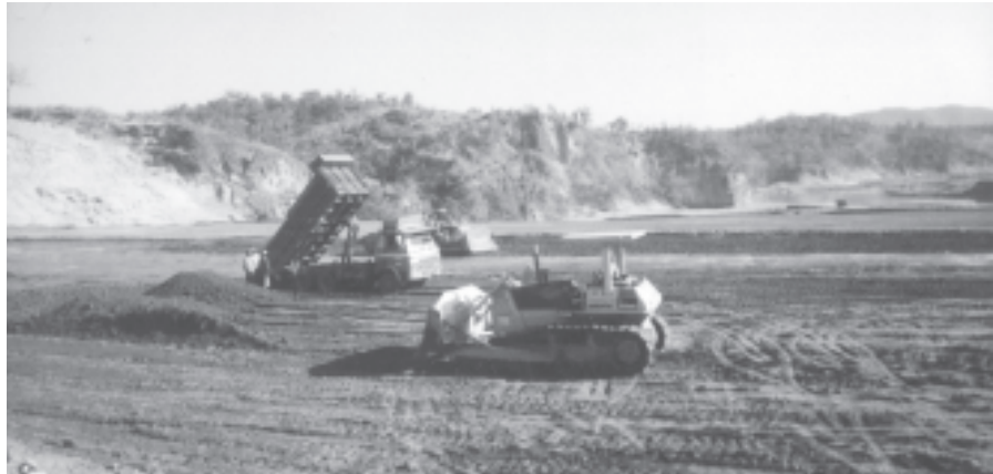
ကြီးအုံ-ကြီးဝ ရေလှောင်တံစံကို ဤကဲ့သို့ စက်ယန္တရားကြီးများဖြင့် တည်ဆောက်နေသည်။
