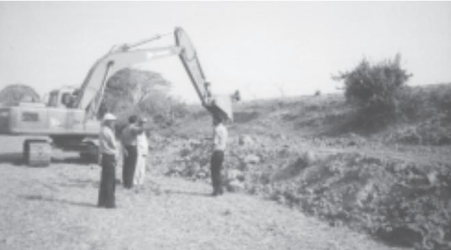
ကျိုက်တုံမြို့နယ် စည်ပင်သာယာရေးအဖွဲ့မှ ၂၀၀၅-၂၀၀၆ ဘဏ္ဍာရေးနှစ်အတွင်း ဆောင်ရွက်လျက်ရှိသော ကျိုက္ခာသာ-ဗဟန်း ကားလက်မြေသားလမ်း ဖောက်လုပ်ရေးလုပ်ငန်းကို မတ် ၁၃ရက်က ဖန်ပြည်နယ် စည်ပင်သာယာရေးအဖွဲ့ ဒုတိယညွှန်ကြားရေးမှူး ဦးသန်းလှိုင် ကြည့်ရှုစစ်ဆေးရာ အမှုဆောင်အရာရှိ ဦးသက်အောင်နှင့် တာဝန်ခံအင်ဂျင်နီယာ ဦးတင်ထွန်းတို့က ရှင်းလင်းတင်ပြစဉ်။ (မြို့နယ်စည်ပင်)
