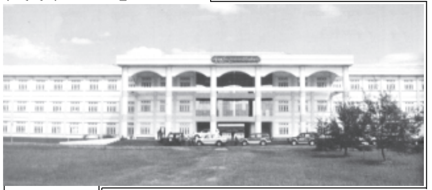
ရခိုင်ပြည်နယ် စစ်တွေမြို့တွင် တည်ဆောက်ထားသော အစိုးရ နည်းပညာကောလိပ် (စစ်တွေ)၏ ပင်မဆောင် (သုံးထပ်ဆောင်)ကို ဤသို့ တွေ့ရသည်။
