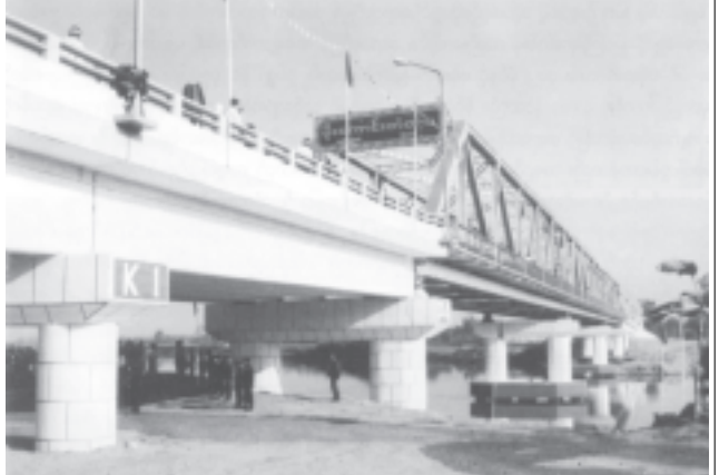
ကချင်ပြည်နယ် လမ်းပန်း ဆက်သွယ်ရေး တိုးတက် ကောင်းမွန်စေရေးအတွက်တည် ဆောက်ပေးခဲ့သော မိုးကောင်း တံတားကို တွေ့ရစဉ်။
