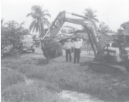
ပဲခူးမြို့နယ် စည်ပင်သာယာရေးအဖွဲ့က မြို့သန့်ရှင်းသစ်ရပ် သာယာလှပရေးနှင့် လမ်းဆေးရေကုတ်မြောင်းများ ရေစီးရေလွှာကောင်းမွန်ရေးအတွက် ဩဂုတ် ၂ ရက်က စက်ယန္တရားကြီးများဖြင့် ရေကုတ်မြောင်းများ တူးဖော်နေမှုကို မြို့နယ်စည်ပင်သာယာရေးအဖွဲ့ အင်ဂျင်နီယာမှူး ဦးမျိုးမင်းသန့် ကြီးကြပ်ဆောင်ရွက်စဉ်။ (မြို့နယ်စည်ပင်)
