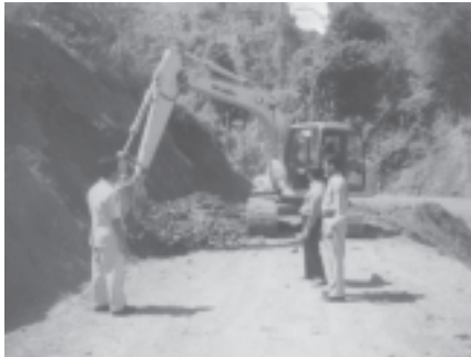
ချင်းပြည်နယ် ဟားခါးမြို့နယ်စည်ပင်သာယာရေးအဖွဲ့က မြို့တွင်း လမ်းများအား လမ်းသားကျယ်စေရန် ဆောင်ရွက်လျက်ရှိရာ မြို့ဟောင်းလမ်း တစ်ချို့ကြီးကို စက်ယန္တရားဖြင့် ဆောင်ရွက်လျက်ရှိရာ မေ ၂၅ ရက်က ချင်းပြည်နယ်စည်ပင်သာယာရေးအဖွဲ့ ညွှန်ကြားရေးမှူး ဦးခင်မောင်နှင့် ဒုတိယ အင်ဂျင်နီယာမှူးကြီး ဦးတင်မောင်တို့ ကွင်းဆင်းစစ်ဆေးစဉ်။ (မြို့နယ်စည်ပင်)
