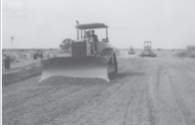
မန္တလေးတိုင်း တံတားဦးမြို့နယ်အပိုင်း ခရိုင်ချင်းဆက်လမ်းဖောက်လုပ်မှုကို စက်ယန္တရားများဖြင့် ဆောင်ရွက်နေစဉ်။
