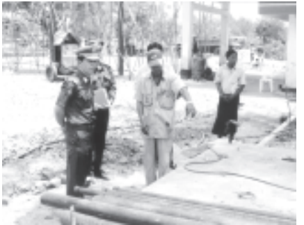
စွမ်းအင်ဝန်ကြီးဌာန ဒုတိယဝန်ကြီး ဗိုလ်မှူးချုပ်သန်းဌေး လှိုင်သာယာ မြို့နယ်ရှိ သဘာဝဓာတ်ငွေ့အရောင်းဆိုင်အမှတ်(၁၁၁) တည်ဆောက်နေမှု လုပ်ငန်းများ ကြည့်ရှုစစ်ဆေးစဉ်။ (စွမ်းအင်)
