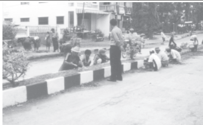
ဩဇာတိ ၂၇၇ကက မြဝတီမြို့ ဘုရင်နောင်လမ်းကြေးတစ်လျှောက်ရှိ ပလက်မောင်းနှင့် လမ်းလယ်ကွန်များ ပြုပြင်ဆေးသုတ်နေမှုအား ဖြို့ဖယ် စဉ်ပင်သာယာရေးအဖွဲ့ အမှုဆောင်အရာရှိ ဦးခင်မောင်သန်း ကြည့်ရှု စစ်ဆေးစဉ်။
