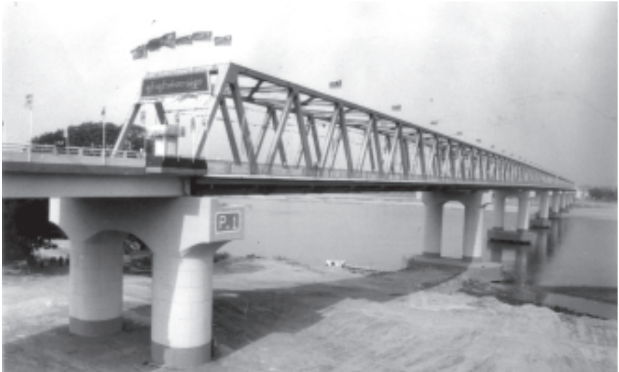
လမ်းပန်းဆက်သွယ်ရေးကဏ္ဍ ဖွံ့ဖြိုးတိုးတက်ရေးအတွက် နိုင်ငံတော်က မြစ်ကူးတံတားကြီးပေါင်း ၁၇၂ စင်းကို တည်ဆောက်ပေးခဲ့ ရာတွင် စစ်ကိုင်းတိုင်းရှိ ချင်းတွင်းတံတား(မုံရွာ)သည်လည်း တစ်စင်းအပါအဝင်ဖြစ်သည်။ (ဓာတ်ပုံ-ကြေးမုံ)
