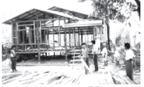
သုံးစွဲမြို့နယ် စည်ပင်သာယာရေးအဖွဲ့က ကြီးကြပ်ဆောင်ရွက်လျက်ရှိသော ကမြင့်ကျေးရွာရှိ ကျေးလက်အိမ်ရာ တည်ဆောက်ပြီးစီးမှုကို ဇူလိုင် ၁၈ ရက်က အမှုဆောင်အရာရှိ ဦးသန်းဌေးနှင့် လက်ထောက်အင်ဂျင်နီယာ ဦးမျိုးမျိုးတို့ ကွင်းဆင်းကြည့်ရှုစစ်ဆေးစဉ်။ (မြို့နယ်စည်ပင်)
