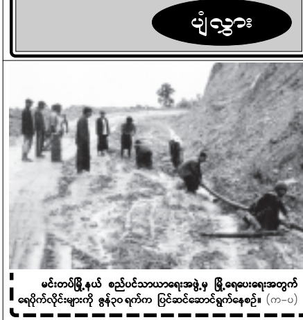
မင်းတပ်မြို့နယ် စည်ပင်သာယာရေးအဖွဲ့မှ ဖြိုရပေးရေးအတွက် ရေပိုက်လိုင်းများကို ဇွန် ၃၀ ရက်က ပြင်ဆင်ဆောင်ရွက်နေစဉ်။ (က-ပ)
