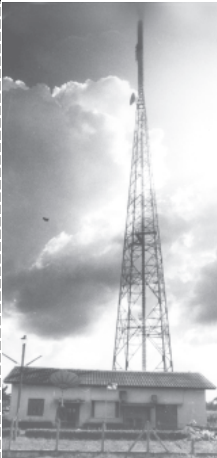
ကျေးလက်ဒေသဖွံ့ဖြိုးတိုးတက်ရေးအတွက် ဧရာဝတီတိုင်း ကျောင်းကုန်းမြို့တွင် နိုင်ငံတော်က တည်ဆောက်ပေးထား သည့် ရုပ်မြင်သံကြား ထပ်ဆင့်လွှင့်စက်ရုံကို တွေ့ရစဉ်။ (ဓာတ်ပုံ-ခင်မောင်ဝင်း ကြေးမုံ)
