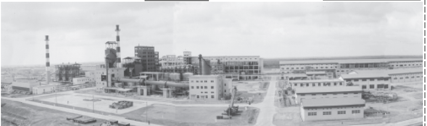
ဧရာဝတီတိုင်း သာပေါင်းမြို့နယ်တွင် တည်ဆောက်လျက်ရှိသော တစ်နေ့တန် ၂၀၀ ကျ ပျော့ဖတ်စက်ရုံ စီမံကိန်းလုပ်ငန်းများ ပြီးစီးမှုအခြေအနေကို တွေ့ရစဉ်။
