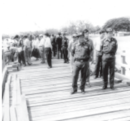
ဧပြီ ၂၄ရက်က နိုင်ငံတော်အေးချမ်းသာယာရေးနှင့် ဖွံ့ဖြိုးရေးကောင်စီဝင်၊ ကာကွယ်ရေးဝန်ကြီးဌာနမှ ဒုတိယဗိုလ်ချုပ်ကြီးရဲမြင့် ယမားချောင်းတံတား တည်ဆောက်ရေးလုပ်ငန်းတွင် ကြည့်ရှုစစ်ဆေးစဉ်။ (သတင်း-၉)
