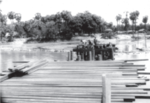
ဧပြီ ၂၄ရက်က နိုင်ငံတော်အေးချမ်းသာယာရေးနှင့် ဖွံ့ဖြိုးရေးကောင်စီဝင်၊ ကာကွယ်ရေးဝန်ကြီးဌာနမှ ဒုတိယဗိုလ်ချုပ်ကြီးရဲမြင့် ယမားချောင်းတံတား တည်ဆောက်ရေးလုပ်ငန်းတွင် ကြည့်ရှုစစ်ဆေးစဉ်။ (သတင်း-၉)
