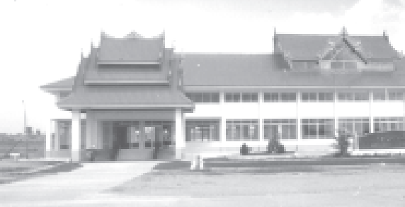
မကွေးမြို့ရှိ မကွေးလေဆိပ် အဆောက်အအုံ
