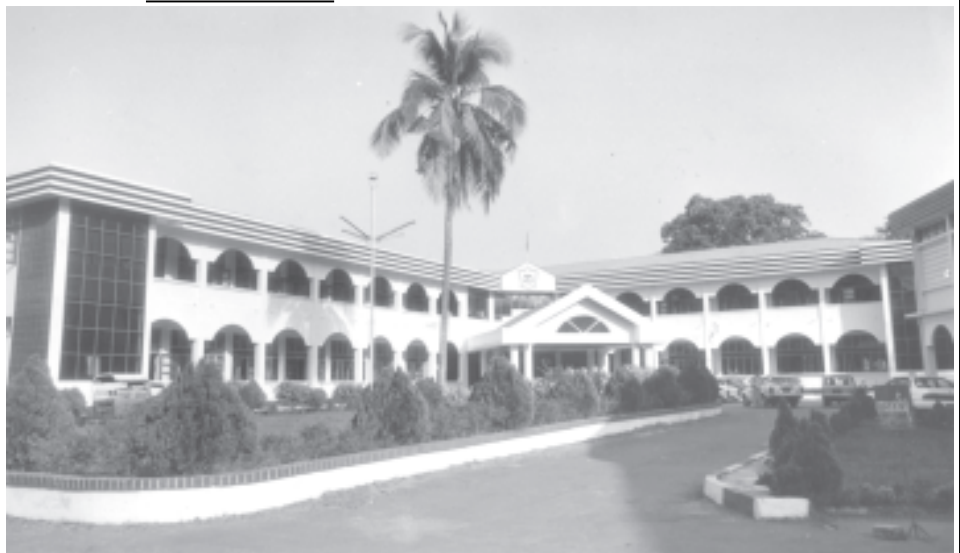
ရန်ကုန်မြို့ ဗဟန်းမြို့နယ် ငါးထပ်ကြီးဘုရားလမ်းရှိ တိုင်းရင်းဆေးရုံ(ရန်ကုန်)ကို တွေ့ရစဉ်။
