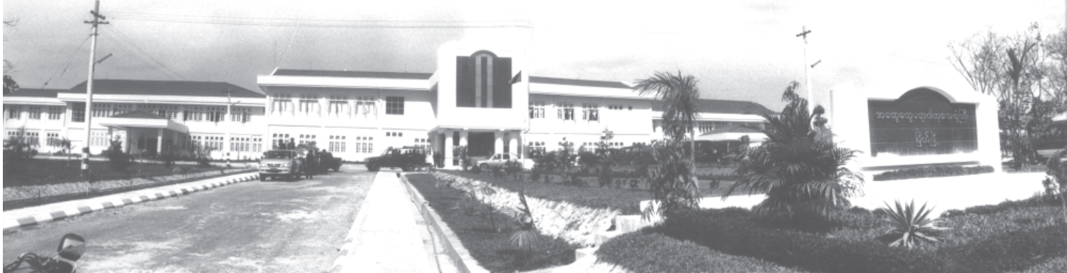
တနင်္သာရီတိုင်း မြိတ်မြို့ရှိ ခုတင် ၂၀၀ ဆံ အထွေထွေရောဂါကု ဆေးရုံသစ်ကြီး(မြိတ်)အဆောက်အအုံကို တွေ့ရစဉ်။
