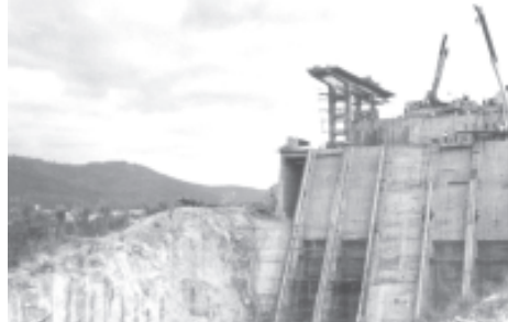
ပေါင်းလောင်းရေလှောင်တံ ပေါင်းလောင်းရေလှောင်တံမံ ရေယူအဆောက်အအုံ Power Intake ဆောက်လုပ်နေသည့် လုပ်ငန်းခွင်မြင်ကွင်း။
