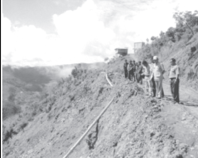
ချင်းပြည်နယ် ဟားခါးမြို့ ရေပေးစရိတ်အတွက် ဖလမ်း-ဟားခါးကားလမ်းတစ်လျှောက် ရေပိုက်များ သွယ်တန်းမှုလုပ်ငန်း ဆောင်ရွက်ကြစဉ်။
