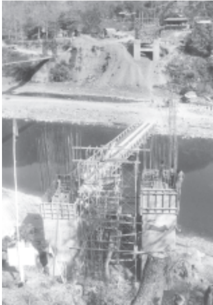
ချင်းပြည်နယ် တီးတိန်မြို့နယ်တွင် တည်ဆောက်လျက်ရှိသော မဲဆောင် ဘေးလီကြီးတံတား တည်ဆောက်မှု မြင်ကွင်းကိုတွေ့ရစဉ်။
