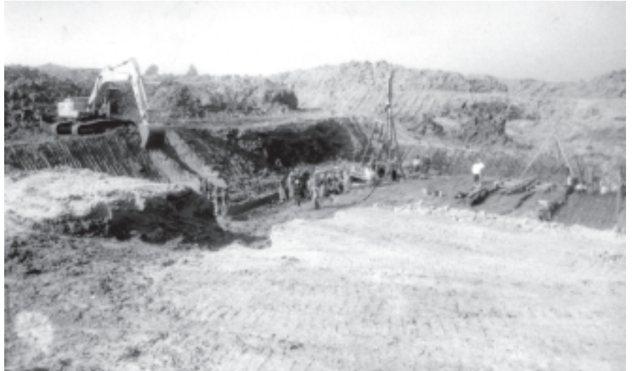
ရန်ကုန် တောင်ပိုင်းခရိုင် သန်လျင်မြို့နယ်တွင် တည်ဆောက်လျက်ရှိသော ခရမ်းရေထိန်းတံခါး၏ အတိဖြစ်မြေကြီးတူးဖော်မှုနှင့် ကွန်ကရစ်လောင်းနေမှုအခြေအနေကို တွေ့ရစဉ်။ (လယ်ယာ/ ဆည်မြောင်း)
