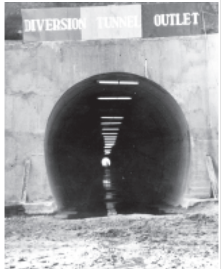
ရဲနွယ်ရေလျှောင်တံမံ ဘက်စုံစီမံကိန်းတွင် ရေလွှဲဥမင်လိုက်တည်ဆောက်ပြီးစီးသွားသောကြောင့် အချောသပ်ပြုပြင်လျက်ရှိသည့်ကို ရေလွှဲဥမင်အတွက်ပေါက်ဘက်မှ တွေ့ရစဉ်။
