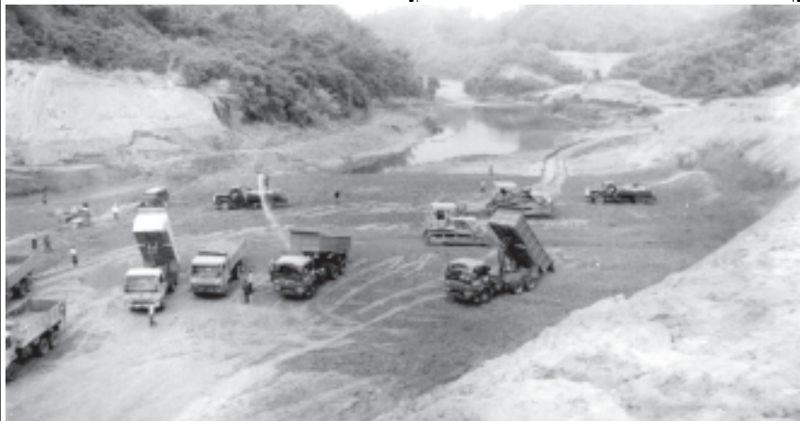
ရဲနွယ်ရေလျှောင်တံမံစီမံကိန်းတွင် ရေလျှောင်ရန်အတွက် တစ်ဖိုရန် ယန္တရားကြီးများဖြင့် ချောင်းပိတ်လုပ်ငန်းဆောင်ရွက်လျက်ရှိသည့်ကို တွေ့ရစဉ်။
