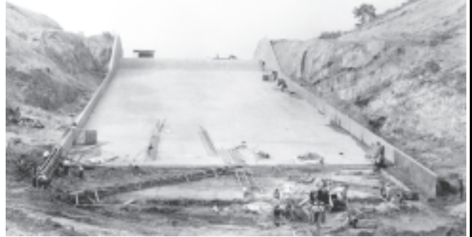
ရဲနွယ်ရေလျှောင်တံမံဘက်စုံစီမံကိန်းတွင် ရေလျှောင်တံမံမဟာဏထက် ကျော်လွန်၍ ဝင်လာသောရေများကို လွှဲပြောင်းပေးရန်တည်ဆောက်လျက်ရှိသည့် အကျယ်ပမာဏ ၁၀၀၊ အလျား ပေ ၈၀၀ ရှိမည့် ရေပိုလွှဲတည်ဆောက်လျက်ရှိသည့်ကို တွေ့ရစဉ်။
