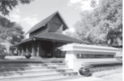
မြန်မာစိုးရာမပျက် ပုံစံထုတ်၍ ခေတ်မီနည်းပညာများဖြင့် ဆောက်လုပ်ထားသော အဆင့်မြင့် (Eden BBB) Restaurant အဆောက်အအုံ၏ နံညားထူပူမှုကို တွေ့ရစဉ်။
